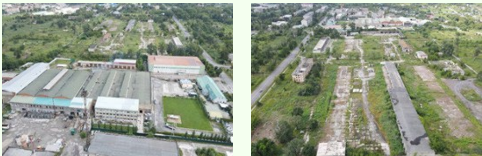
Обзорный снимок инвестиционной площадки «Социально-производственная»
