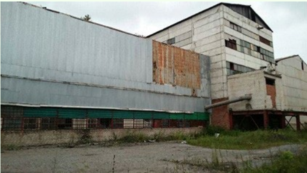
Обзорный снимок инвестиционной площадки «Инвестиционная площадка № 8 (СКАЦИ)»
